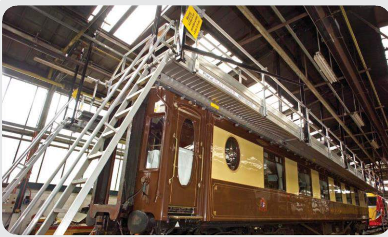
Spandek utilizada para conseguir un acceso más próximo para el mantenimiento del techo del famoso Orient Express.
