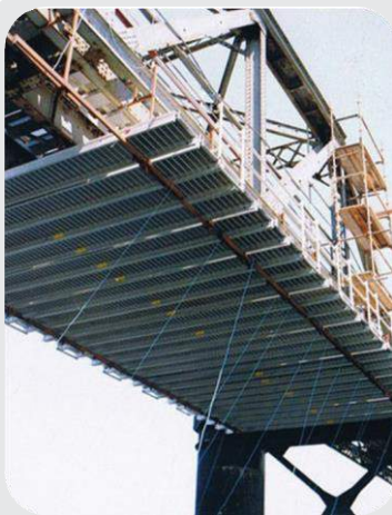
La unión de Spandeks ofrecen una plataforma para obras de reforma bajo puentes.
