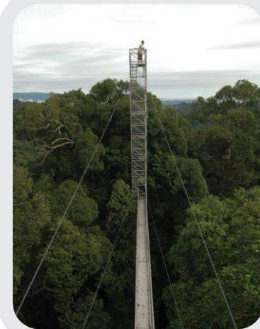
Una Spandek ancho sencillo proporciona una pasarela a la torre de observación en la selva de Brunei.
