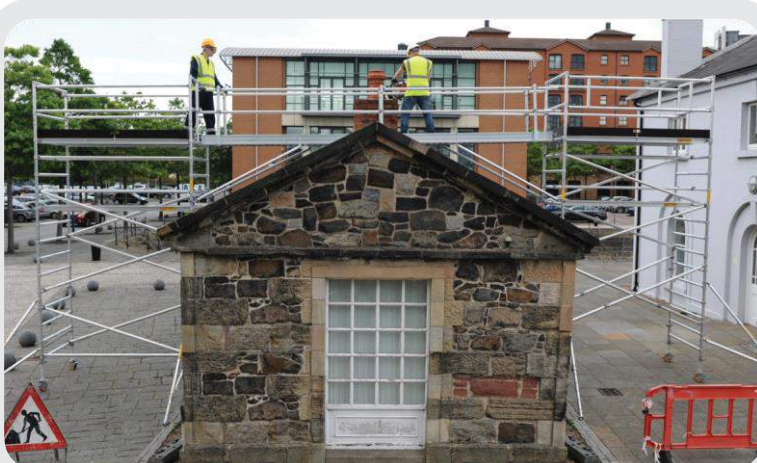
Spandek conecta 2 torres para el mantenimiento de la chimenea en Belfast.
